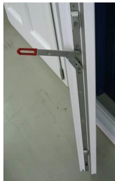
Slika 3: mehanizem za odpiranje dvokrilnega okna ali balkonskih vrat brez pokončnika
