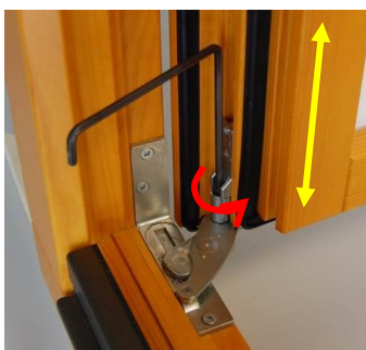
Slika 35: nastavitev krila po višini
