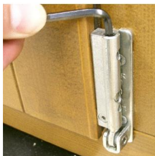
Slika 20: nastavitev okna po višini (spodnji tečaj)
