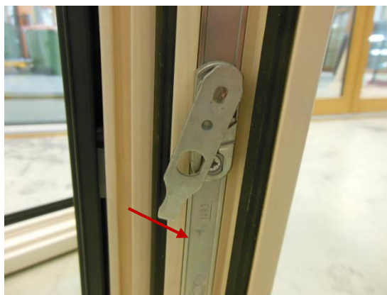
Slika 36: prestavitev nivojnega varovala v vertikalni položaj
