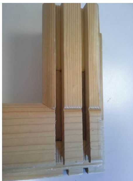
Slika 62: prerez detajla M SORA okna z moznično vezjo in vidnimi mozniki
