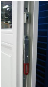
Slika 3: mehanizem za odpiranje dvokrilnega okna ali balkonskih vrat brez pokončnika
