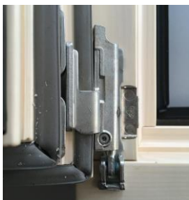
Slika 21: pritisk krila k okvirju (spodnji tečaj)
