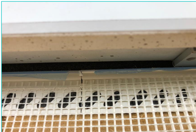
Slika 15: BG1 trak med vogalnikom na fasadi ter polico, ki je prilepljena z lepilom MS.
