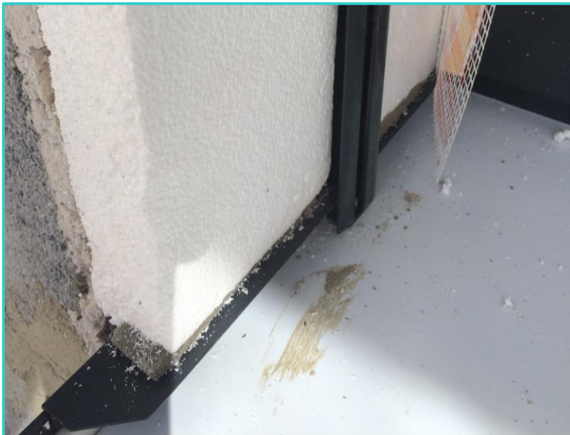
Slika 13: BG1 trak med končnikom ter izolacijo špalete
