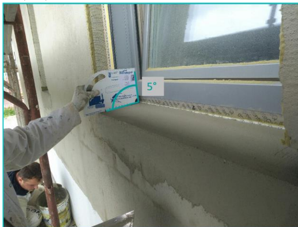
Slika 3: Kontrola priprave ležišča v naklonu 5° s šablono
