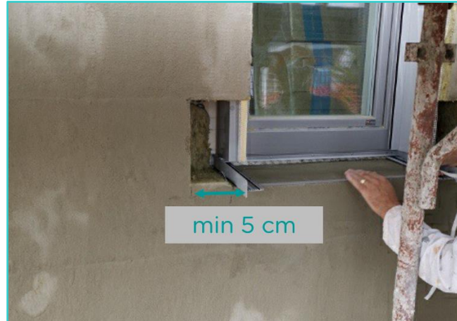
Slika 5: Priprava prostora za vgradnjo police (levo in desno)
